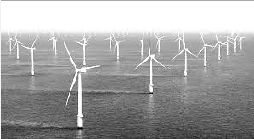
Рис. 2.14. Розміщення вітроелектростанції Walney Extension (Велика Британія) у відкритому морі
