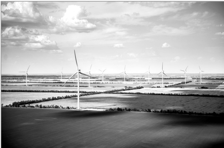
Рис. 2.17. Ботієвська ВЕС (Запорізька область)
