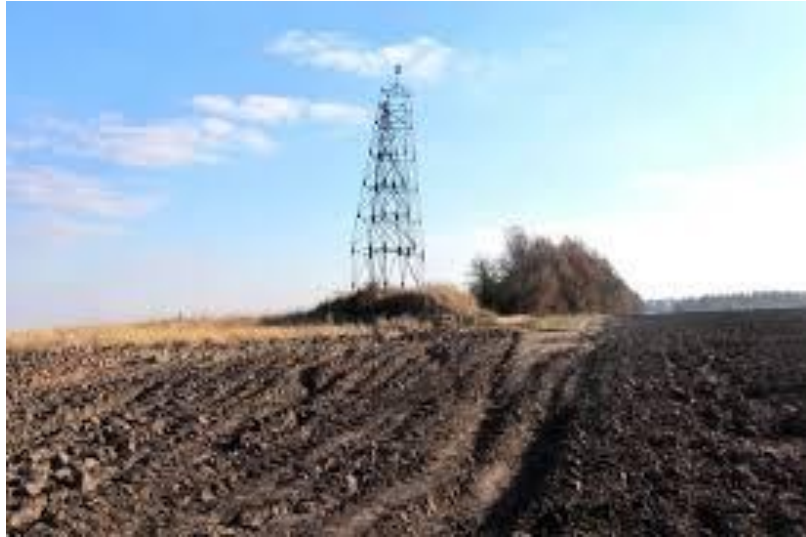
Центри пунктів мають різну конструктивну будову, яка залежить від особливостей ґрунту і фізико-географічних умов району. Вони являють собою систему двох пілонів, центри яких суворо збігаються (мал.6.8). У верхній частині першого пілона закріплена металева марка. Центром її є точка, координати якої визначаються. Зовнішній знак - металева піраміда, навколо якої - канава трапецієподібного перерізу.
